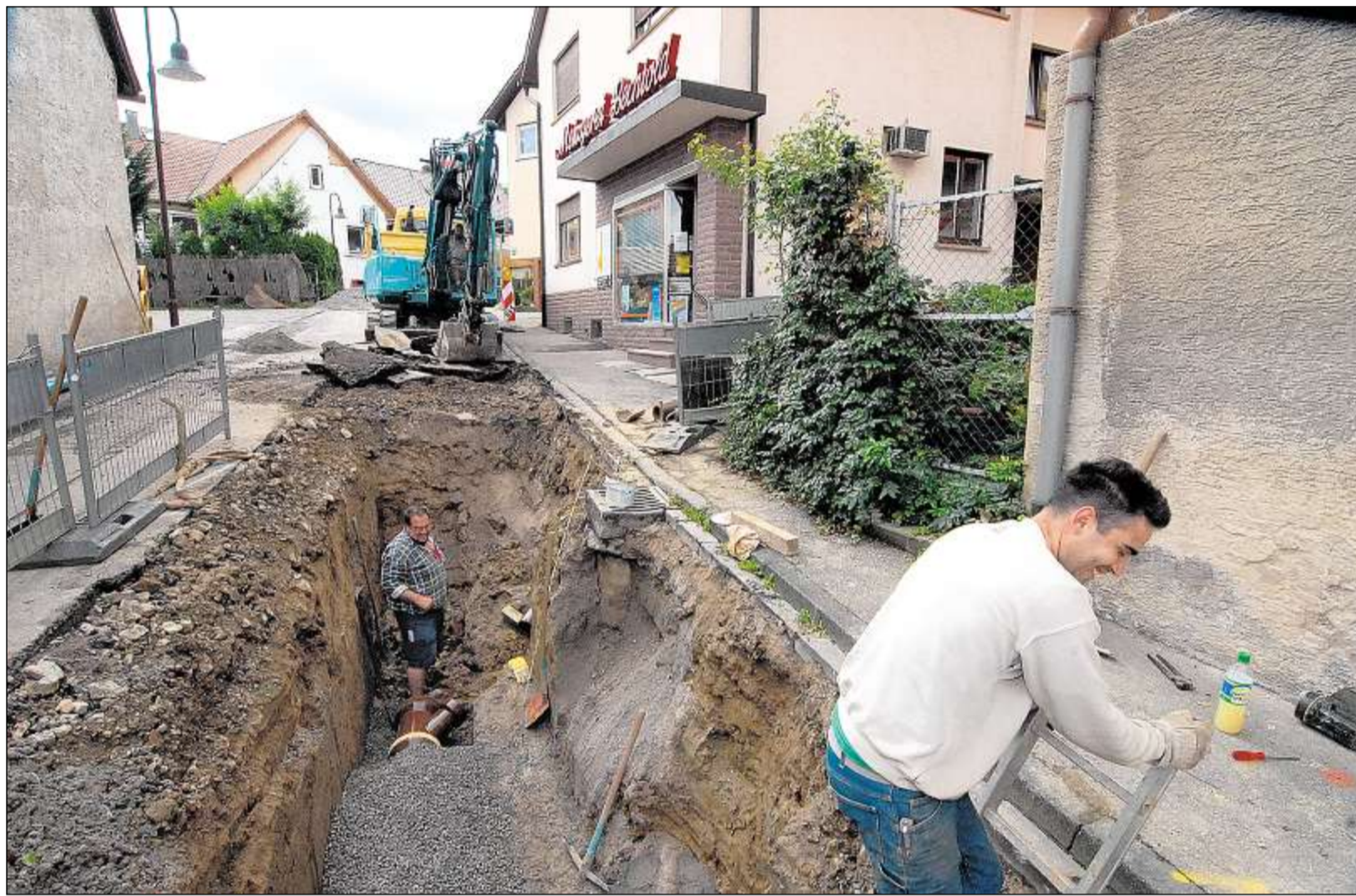
MIT DER NEUGESTALTUNG der Metzgerstraße sind die Sanierungsmaßnahmen „Ortsmitte Bilfingen“ angelaufen. In drei Meter Tiefe wird die Kanalisation erneuert, dann folgen neue Wasserleitungen, schließlich folgt ein Altstadtpflasterbelag und teils ein Schwarzbelag. Foto: Manfred Schott
